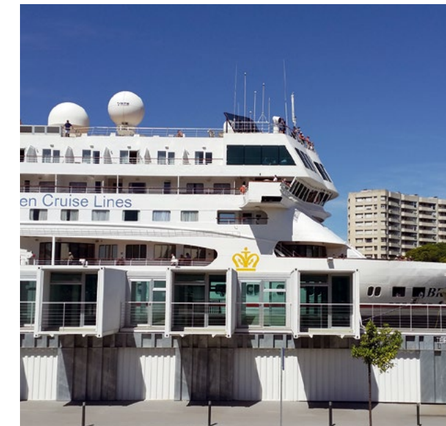
Fachada de la Terminal de Cruceros en el Puerto de Sevilla. / Façade of the Cruise Ship Terminal in the Port of Seville.
