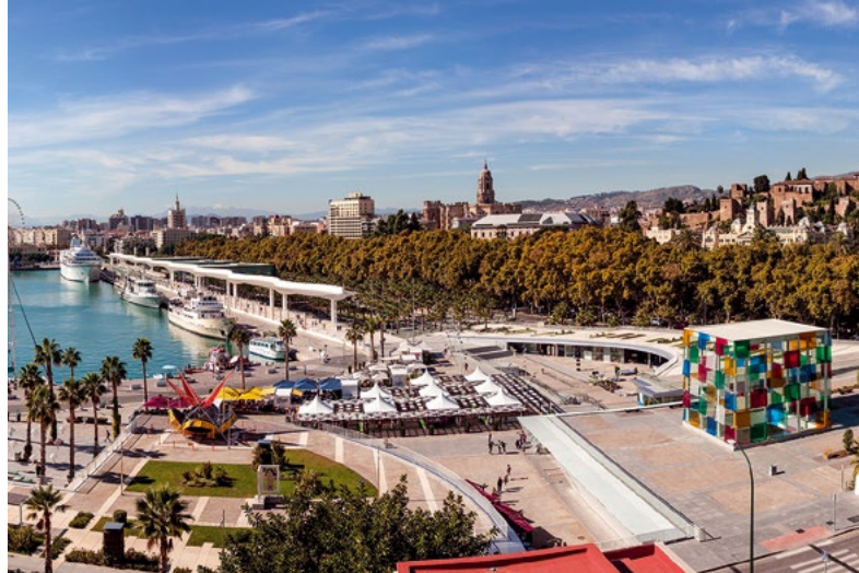
Vista general de la zona de atraque Guadiaro-Palmeral de las Sorpresas. / General view of the Guadiaro-Palmeral de las Sorpresas berthing area.
